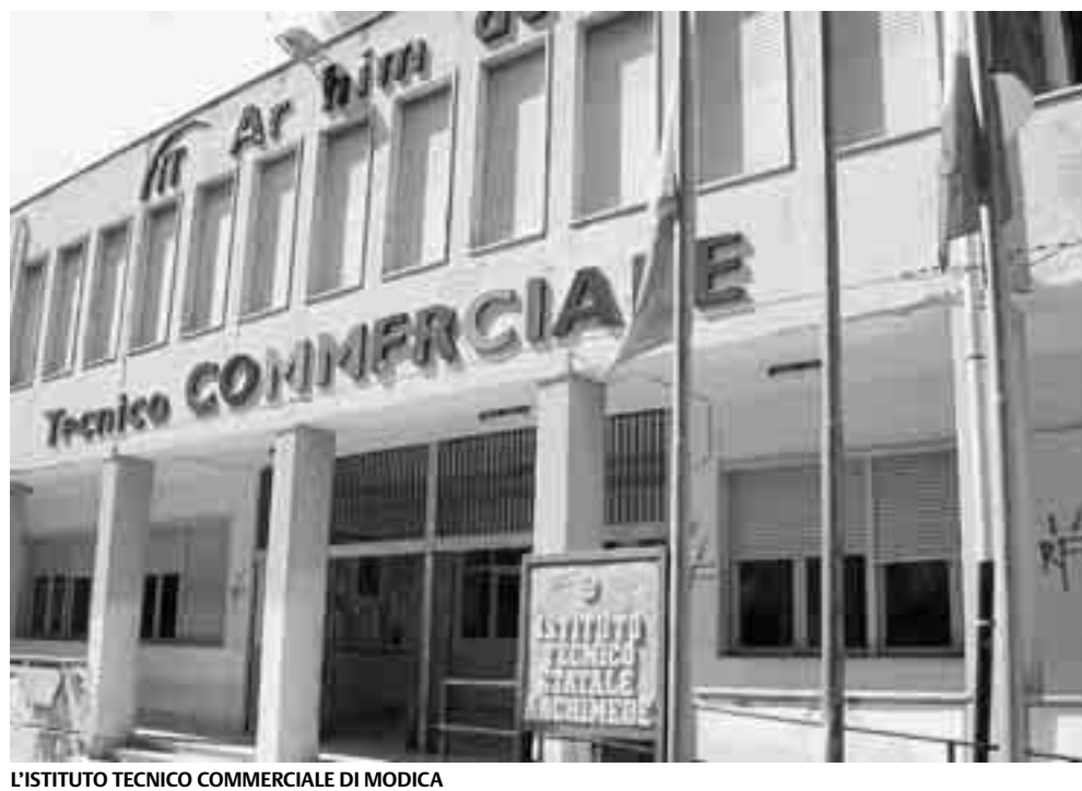
L'ISTITUTO TECNICO COMMERCIALE DI MODICA
